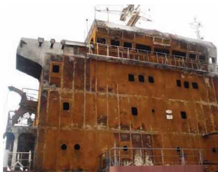
Superestrutura queimada pelo incêndio.
